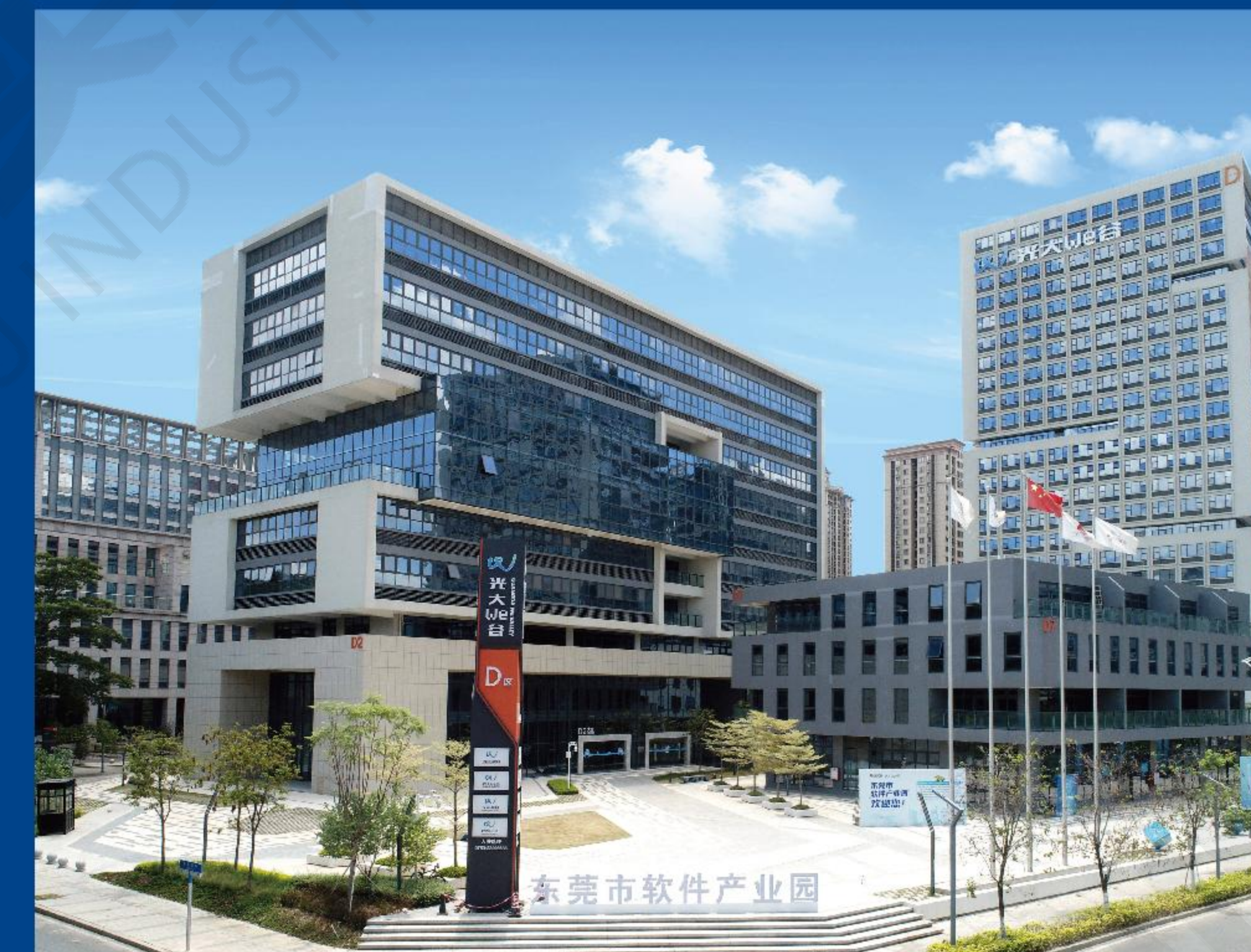
金云东莞数字园项目工程
